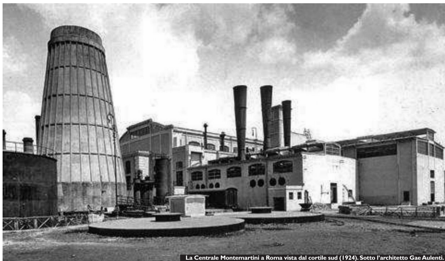
La Centrale Montemartini a Roma vista dal cortile sud (1924). Sotto l'architetto Gae Aulenti.
